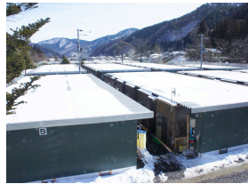
仮設住宅（グラウンド）
