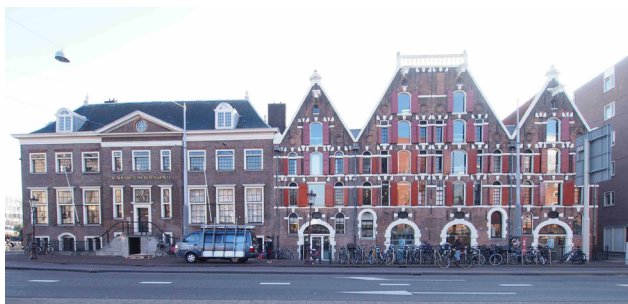
AvBA 正面外観全景 (2 棟が内部で繋がれている)
