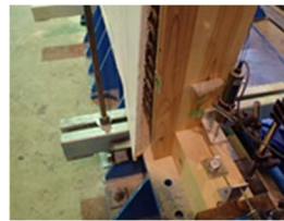
(a) 漆喰のはらみ出し
