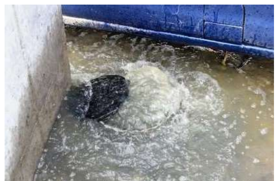
下水道処理場の冠水によりマンホールから汚水噴出（日本経済新聞から）
