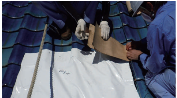
図8. ブルーシートなどのシート材と併用する工法 （撮影：被災屋根応急補修工法開発研究会）
