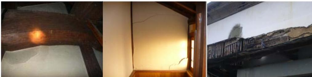
写真 4.3 劣化による部材の強度低下や欠損が起こす壁の膨張、割れや崩落
