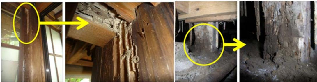
シロアリのよる蟻道（材の表面に付着していると同時に内部を穿孔している）
