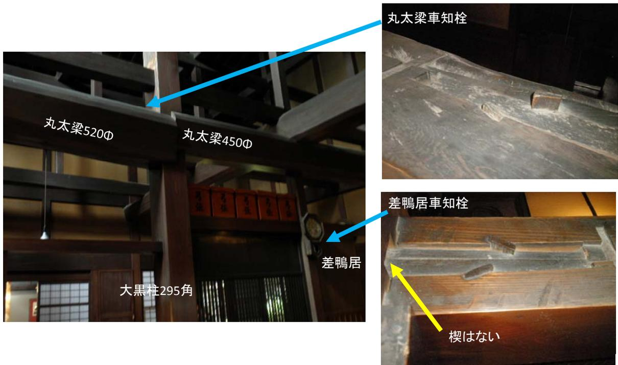
写真 26 丸太梁と差鴨居の車知栓打ち仕口（吉島家）
