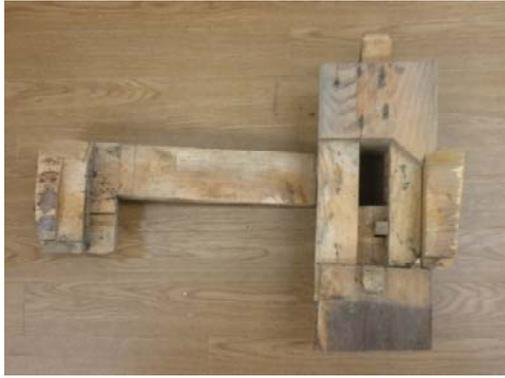
写真 22 仕口内込み栓（解体仕口）
