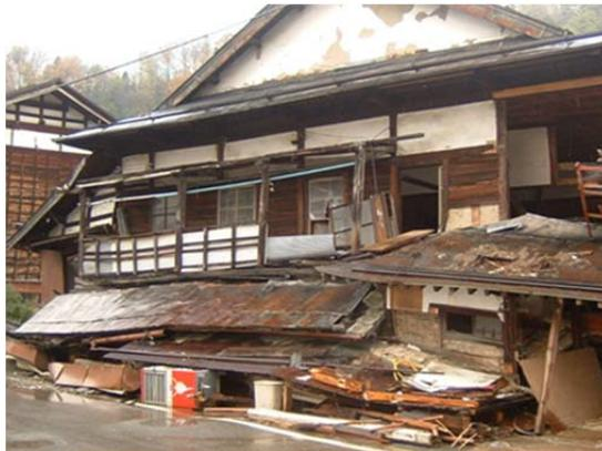
写真1 1階が崩壊した住宅 (左)：在来工法：兵庫県南部地震 (右)：新潟県中越地震
