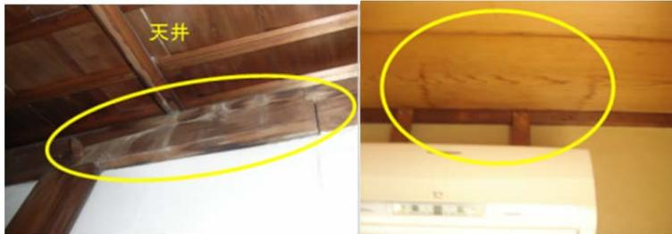
桁や天井板（雨漏りによるため小屋裏の調査が必要）
