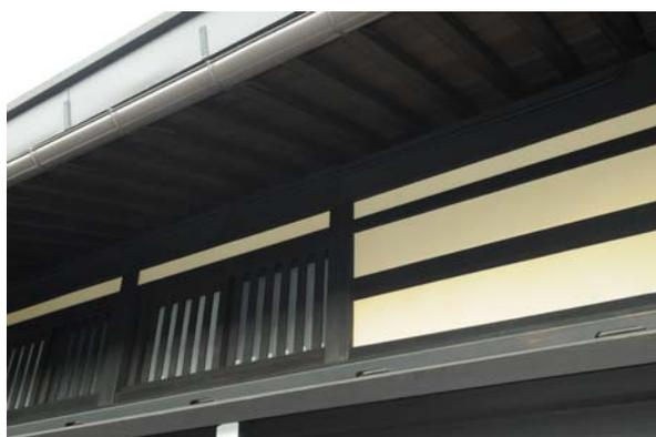
写真 7.3 2階の土塗壁（正面）
