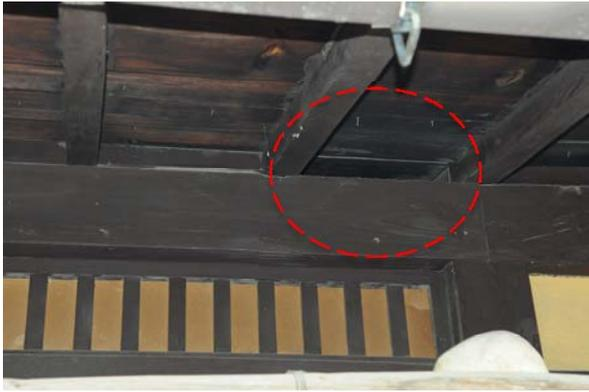
写真 7.5 抜けている面戸板
