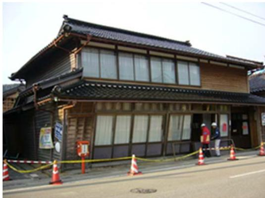
写真2 1階が大きく変形した住宅 (左)：新潟県中越地震 (右)：能登半島地震
