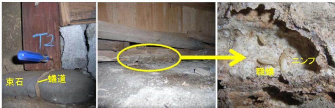
写真 4.7 ドライバの突き刺し診断と内部座から発見されたシロアリ
