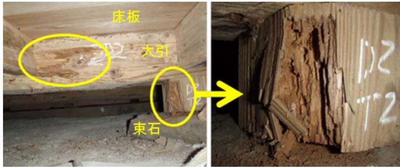
腐朽による束材の座屈
