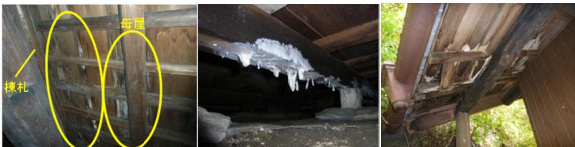
写真 4.6 腐朽菌と関連する付着物
