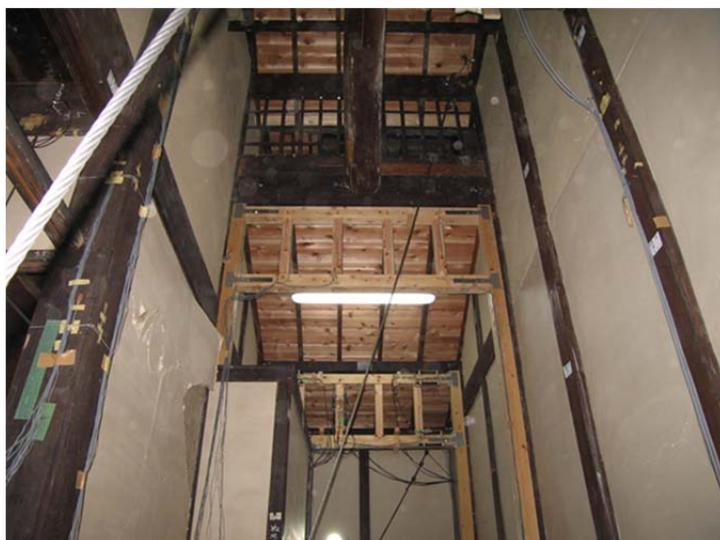
写真3 京町家の通り庭上に設置した「はしご型フレーム」による補強例
