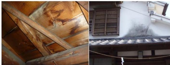
野地板や外壁、野地や内部での腐朽を伴うことが多い
