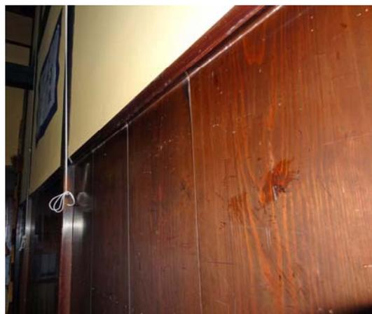
写真11 板壁と土壁を複合した壁
