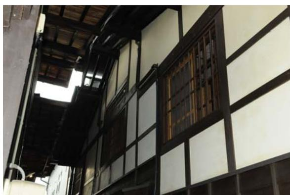
写真 7.4 全面的な土塗壁（側面）
