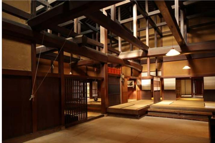
写真3 吉島家の吹き抜け空間と架構
