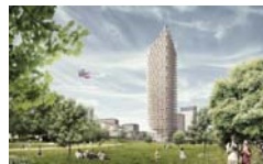
スウェーデンにおけるコンペ案 木造（クロスミナパネル）／S造 による混構造
