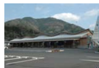
木ならではの加工度の高さを生かし、波型の屋根トラスとした
