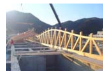
木ならではの加工度の高さを生かし、波型の屋根トラスとした
