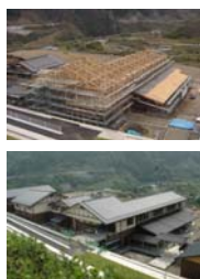
屋根および床をトラス架構とした校舎
