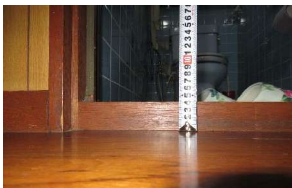
トイレ入口段差 (J)
