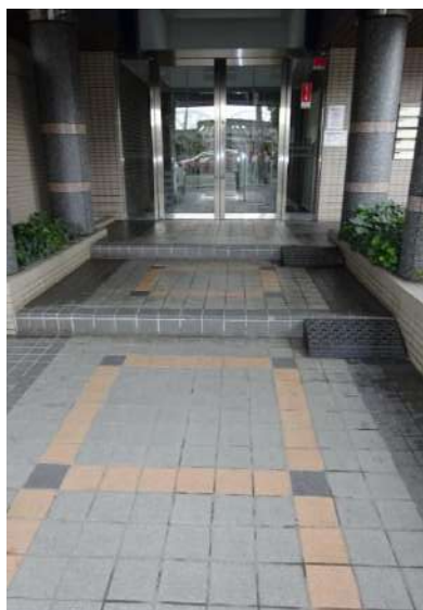
共同住宅 アプローチ 全景
