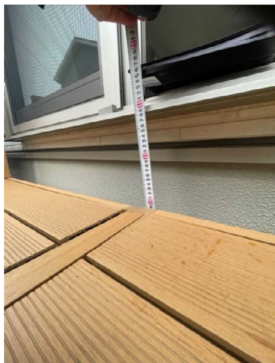
No.45 ウッドデッキの高さ
