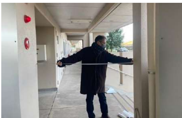
エレベーターホール 入口 有効巾測定
