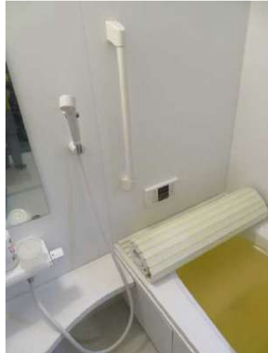
No.38 浴槽出入り用縦手すり
