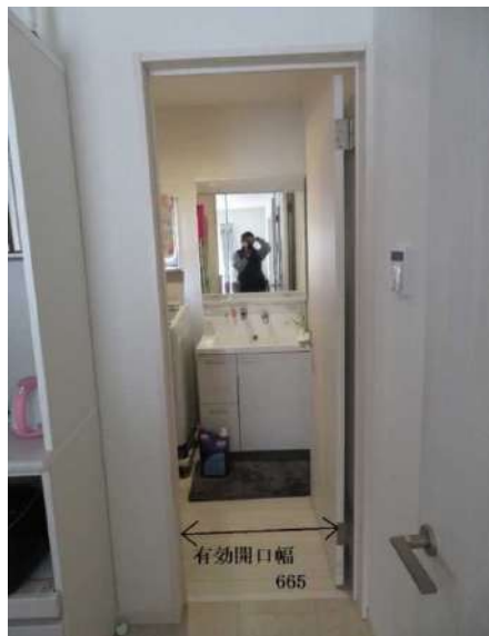
No.25 洗面・脱衣室出入口の有効開口幅
