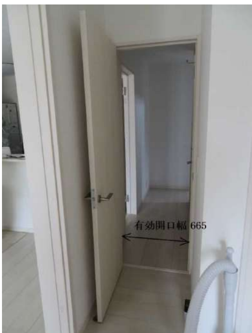
No.21 寝室の廊下側出入口の有効開口幅
