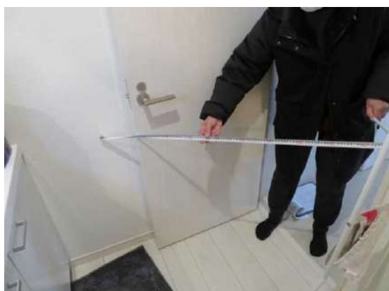
No.27 扉廻りの空き寸法
