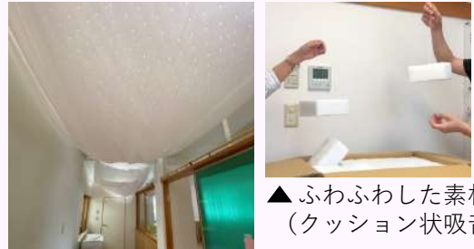
▲ 布状吸音材を廊下の天井部分に仮設。給食室の食器の音がやわらいで聞こえるように。
