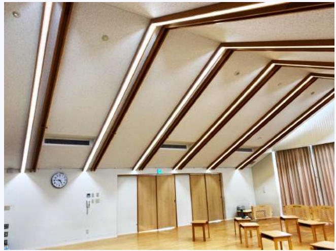
保育園ホール 天井が高く容積の広い空間ですが、天井に岩綿吸音板が使用され響きが抑えられています。
