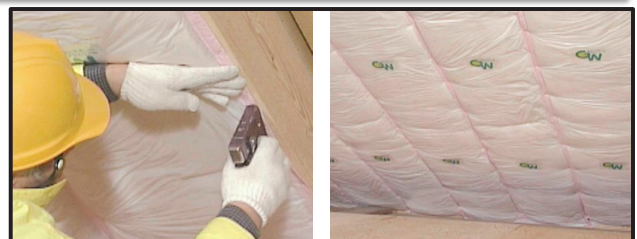
〈屋根の充填断熱の施工〉
